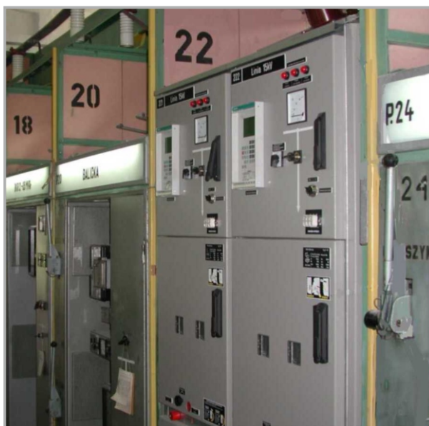
Wymiana pól w czynnej rozdzielni / Replacement of panels in an energized switchgear
