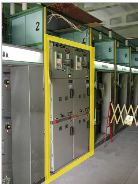
Wymiana pól w czynnej rozdzielni / Replacement of panels in an energized switchgear
